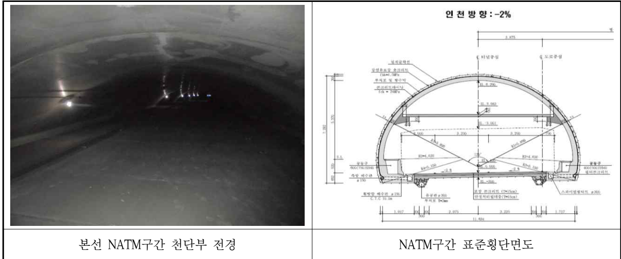
【사진 3.3.5】 NATM구간 천단부 전경
