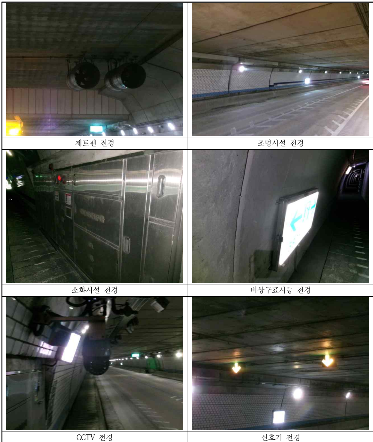
【사진 3.3.45】 부속시설 전경
