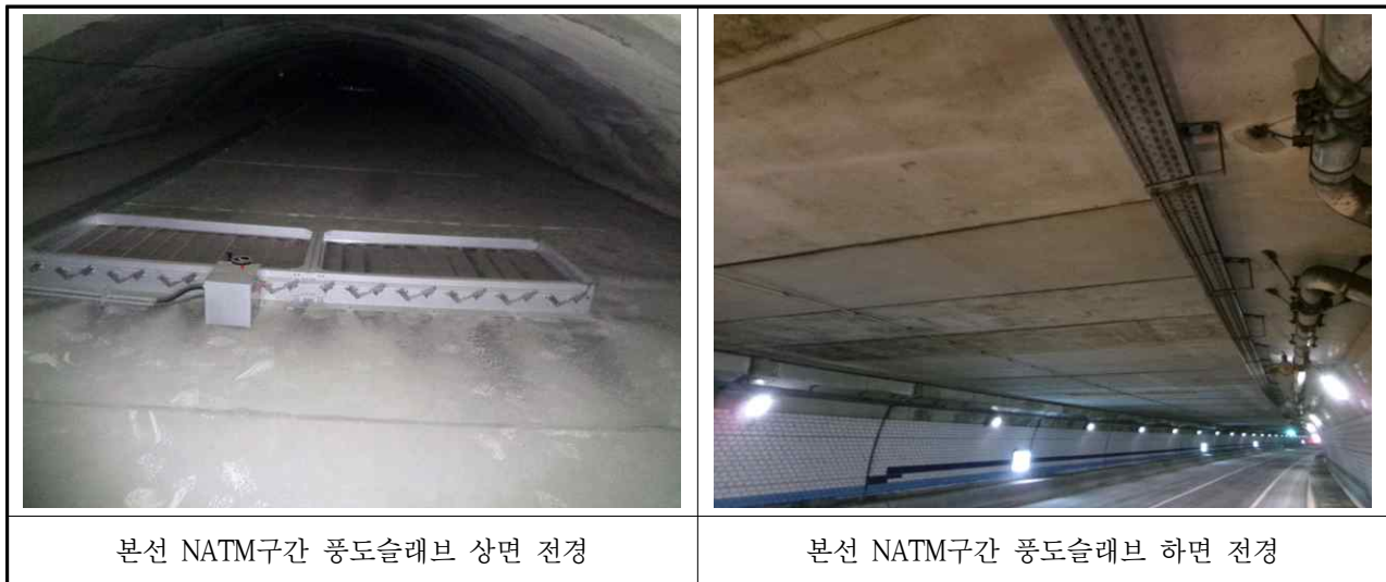
【사진 3.3.9】 NATM구간 풍도슬래브 전경
