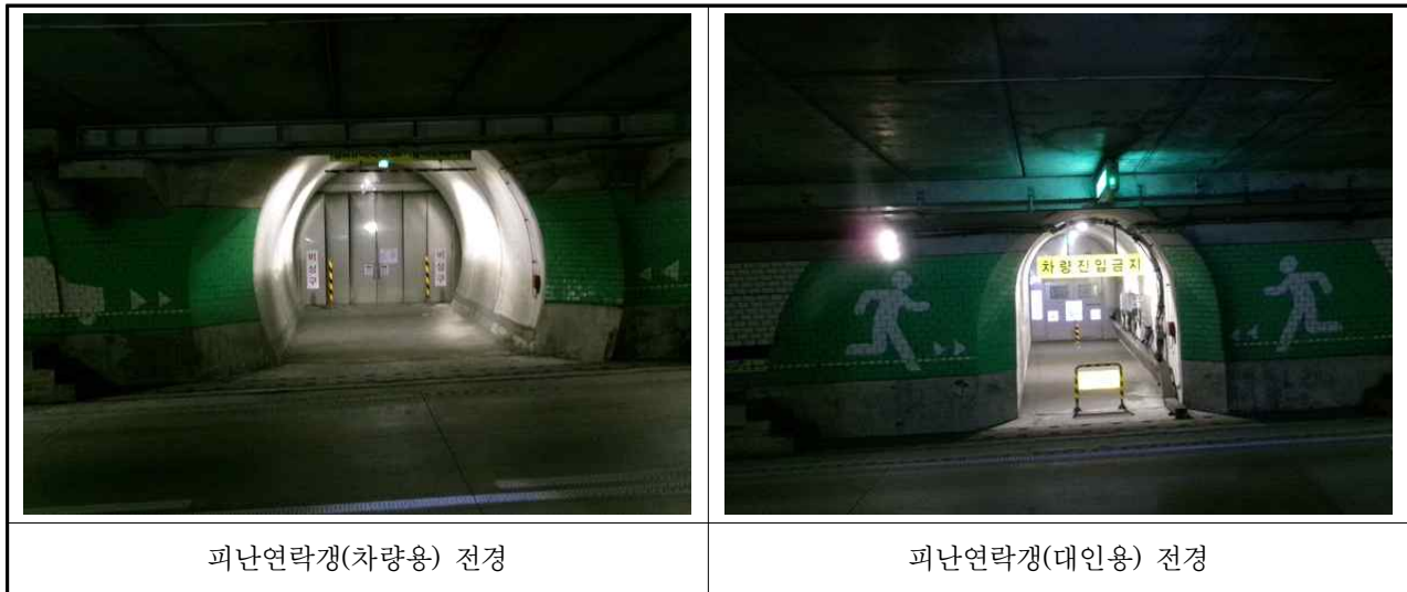
【사진 3.3.37】 피난연락갱 전경
