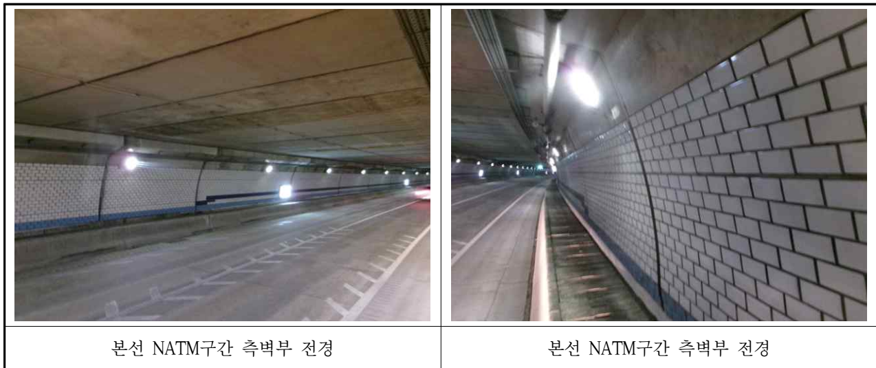
【사진 3.3.7】 NATM구간 측벽부 전경
