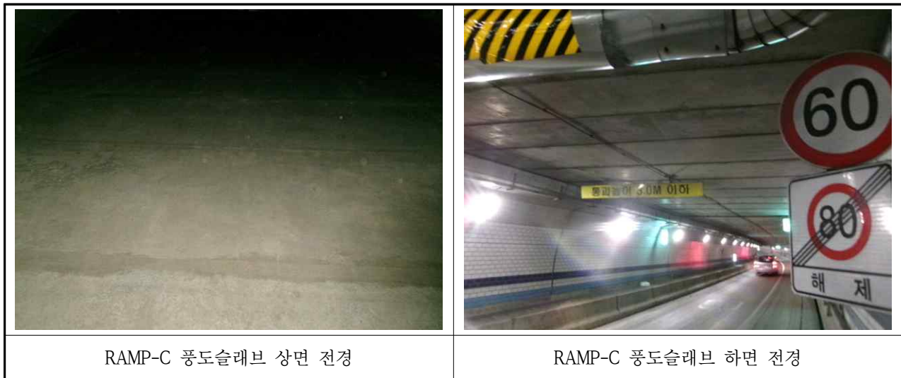
【사진 3.3.27】 NATM구간 풍도슬래브 전경
